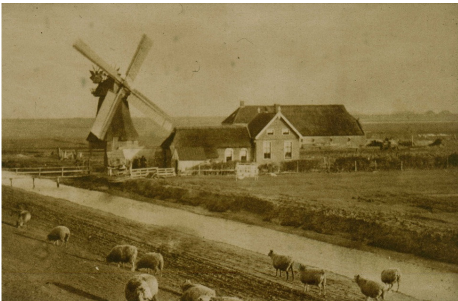
De poldermolen “De Zeemeeuw”, uitgerust met zelfzwichting op beide roeden en achter op de kap een dubbele windroos.
