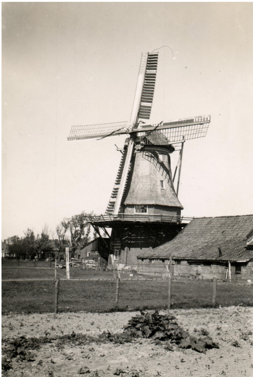
De koren- en pelmolen "De Zwaluw" te Valom in juni 1940. Let op het grote "Friese" raam boven de stelling. De molen is intussen voorzien van een gietijzeren as en zelfzwichting op één roede.
