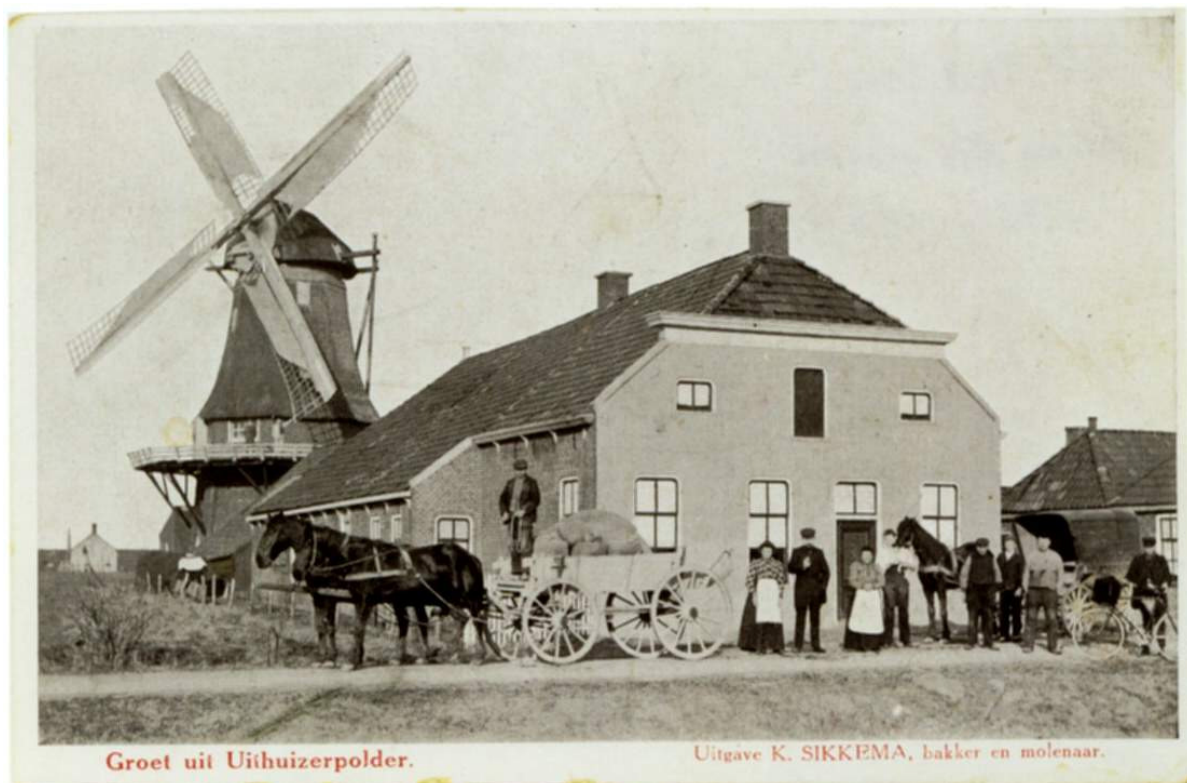
De koren- en pelmolen “De Zwaluw” te Valom in de Uithuizerpolder, vermoedelijk in 1906 gefotografeerd, met de nog bestaande mulderswoning. De molen had toen nog een houten bovenas. Midden onder de zolderdeur in de gevel staan Derk van der Laan met zijn vrouw. (foto: collectie W.O. Bakker)
