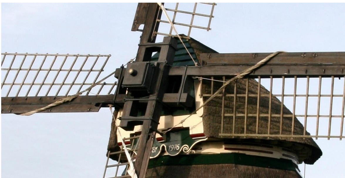
Het haspelkruis van de Robonsbosc molen bij Alkmaar. Auteur Quistnix at nl.wikipedia.
