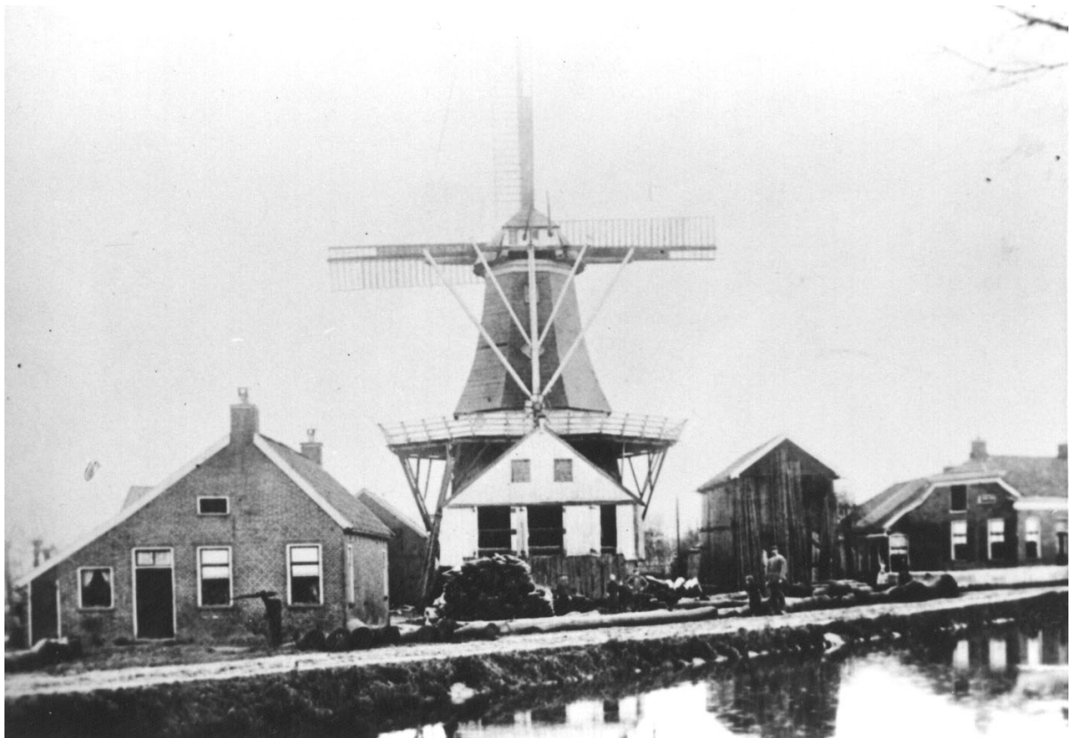
“De Vriendschap” was een achtkante stellingmolen te Eexta, gemeente Scheemda aan het Winschoterdiep met twee functies, n.l.: houtzaagmolen met drie zaagramen en korenmolen met twee koppels maalstenen. Gebouwd 1841, onttakeld 1920 en gesloopt 1954.
