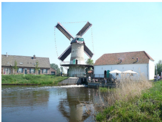
De Kilsdonkse molen draaiend op wind en waterkracht. In het rechter gebouw staat de oliemolen. Tussen dit gebouw en de molen bevindt zich het waterrad. Foto auteur 25-4-2011.
