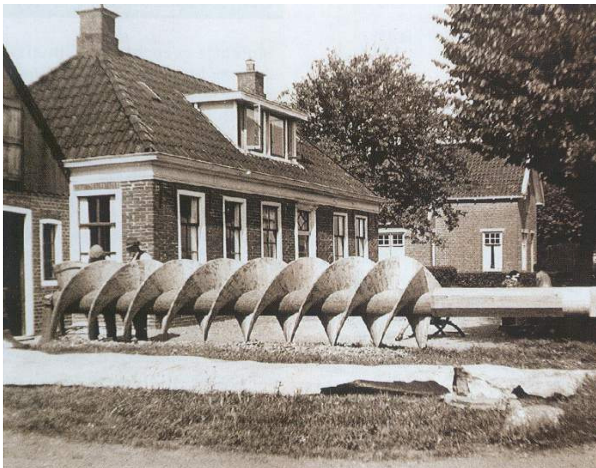
Een houten schroef (vijzel) gemaakt door molenmaker Arend Hazenberg in 1949 te Brittil.
